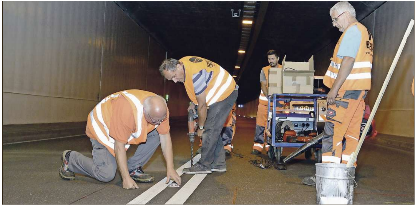
Mehr Sicherheit: Arbeiter bringen reflektierende Markierungsknöpfe in der Fahrbahnmittelpunkt an.
