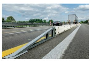
Die transportable Schutzwand erfüllt die Kriterien für die Aufhaltestufe W1 nach DIN FN 1317
