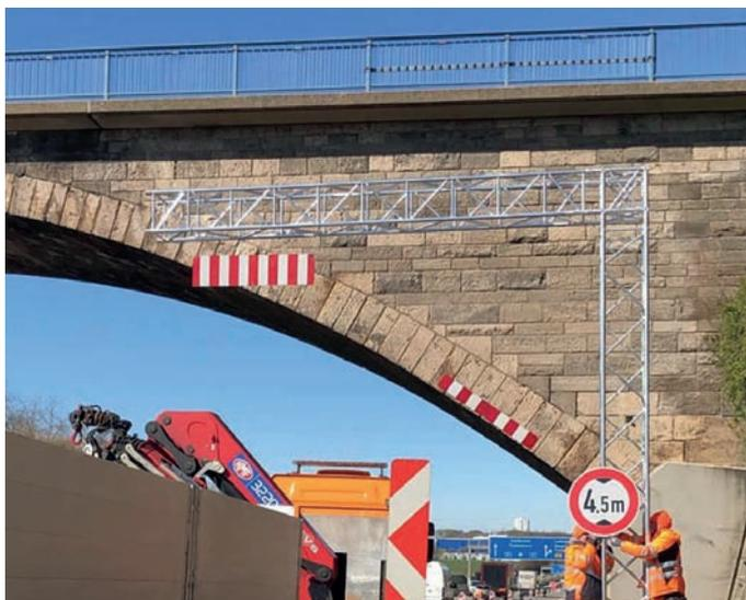
Der Kragarm sorgt für die optimale Visualisierung
