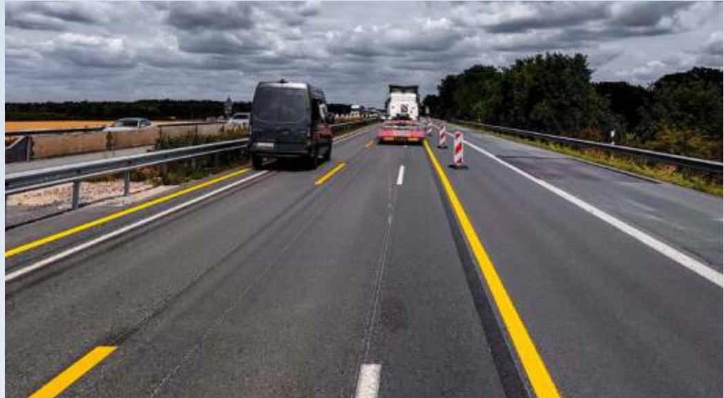
Temporäre Fahrbahnmarkierung mittels Markierungsfolie
