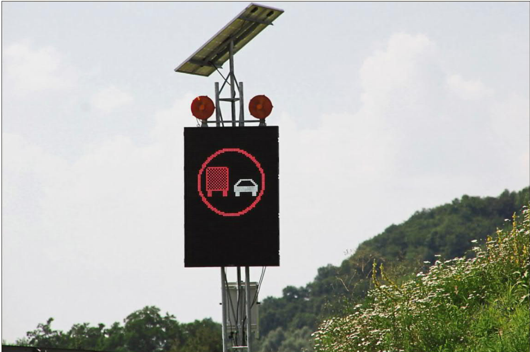
Auf den LED-Paneelen der Stauwarnanlagen zwischen Straubing und Regensburg können auch Meldungen, wie hier ein Überholverbot für Lastwagen, oder Tempolimits angezeigt werden. Nun sollen damit erste Erfahrungen gesammelt und geschaut werden, wie gut das Ganze funktioniert. Fotos: Annabel Gruber
